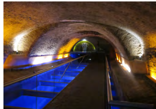
Tunnel Puente de Bubas
